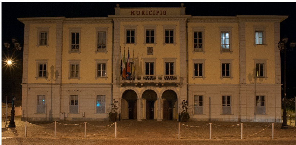
Fig. 4 – Municipio di Nichelino, TO, prima dell'intervento del 2021.
