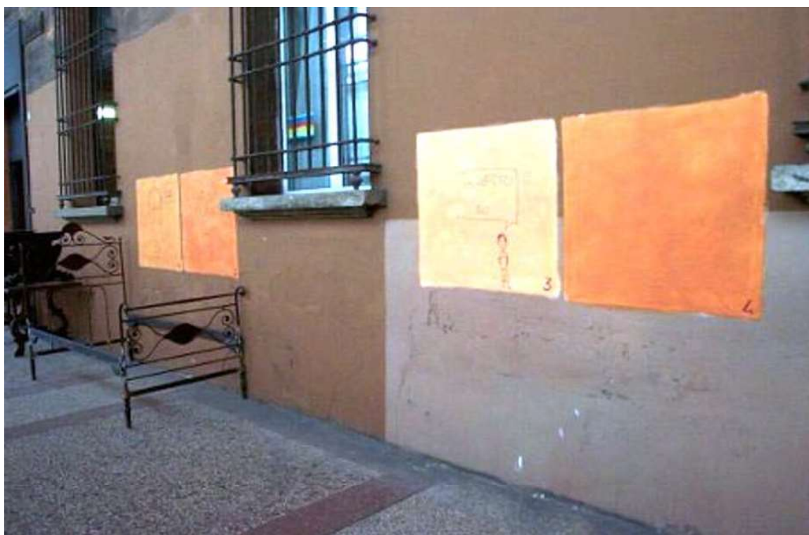
Figura 27. Campionatura cromatica di una facciata del centro storico di Bologna (image courtesy Nicola Santopuoli).
