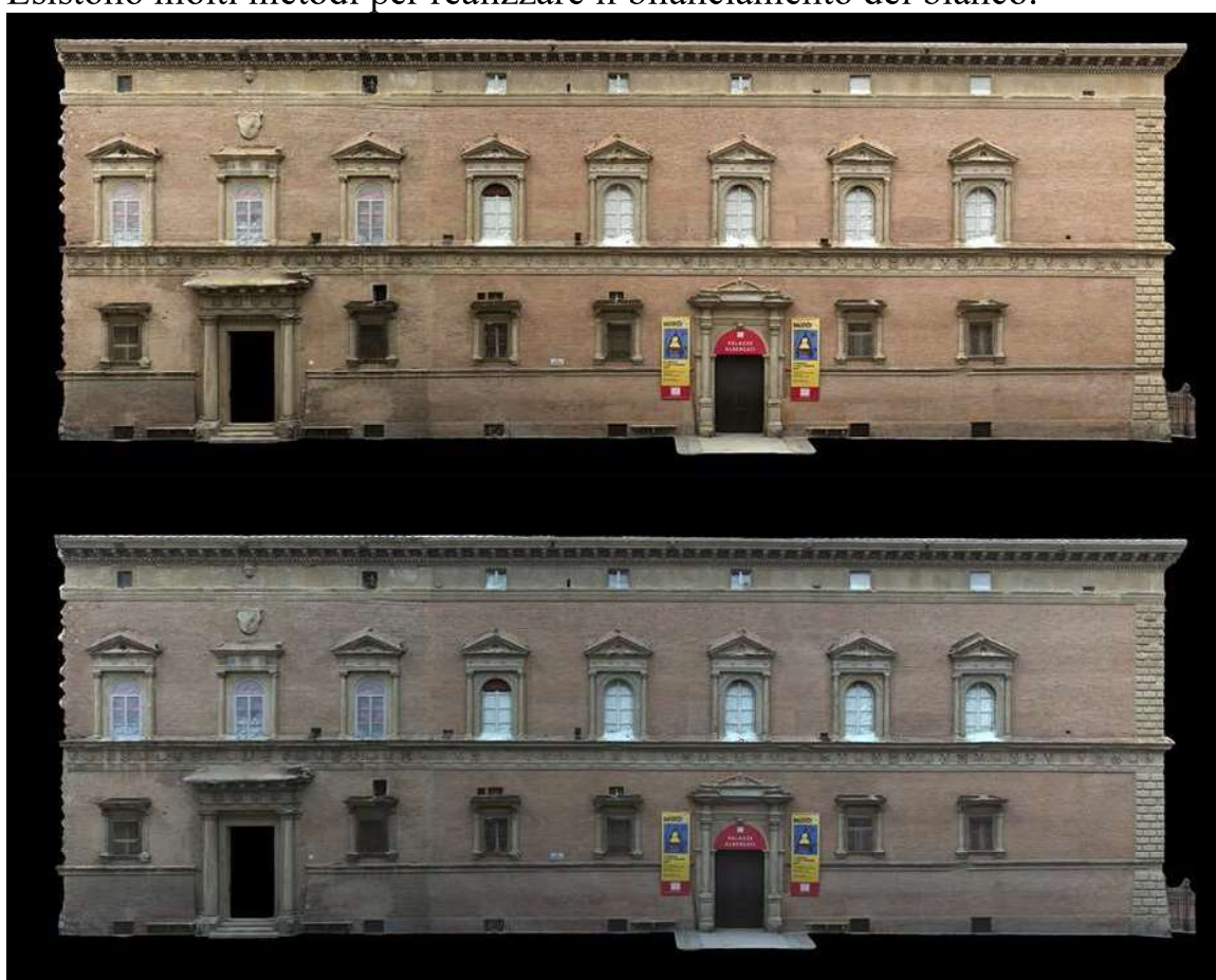
Figura 42. Esempio di bilanciamento del bianco dell'immagine di una facciata di un edificio, in basso prima e in alto dopo l'operazione.
