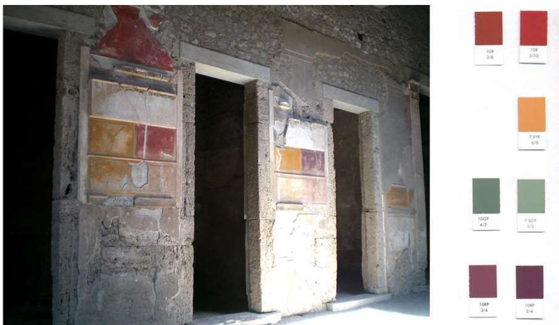
Figura 18. Esempio di utilizzo del Munsell Books of Color per valutare i colori di una parete a finte lastre marmoree dell'atrio della casa di Sallustio a Pompei (image courtesy Patrizia Falzone).
