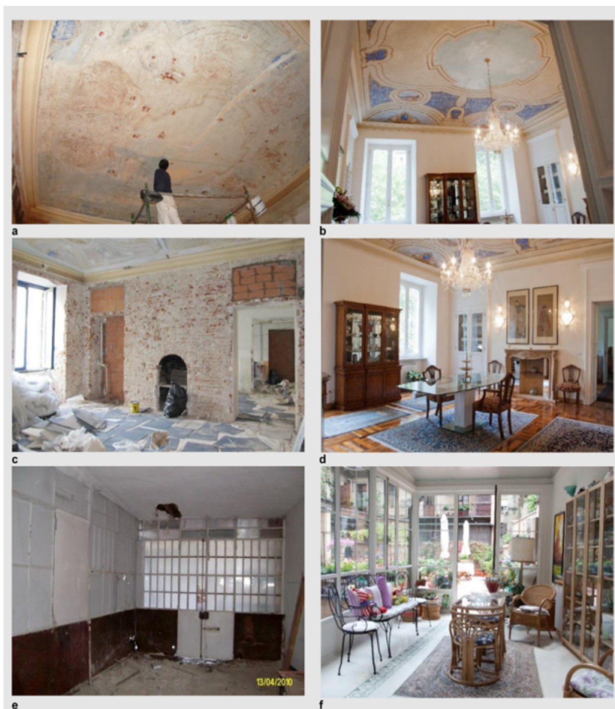
Fig 1 Tracce materiali del passato nel costruito storico. La prospezione e l'interrogazione (anche visiva) della materia originale, una volta eliminate le pesanti e incongrue superfetazioni, hanno svelato aspetti insospettati, come i decori nelle volte dei saloni (a, b) e nelle pareti (c, d). Anche la veranda (e,f) è stata messa in valore, eliminando l'improprio tamponamento, realizzato in periodi diversi (1920-1990)
