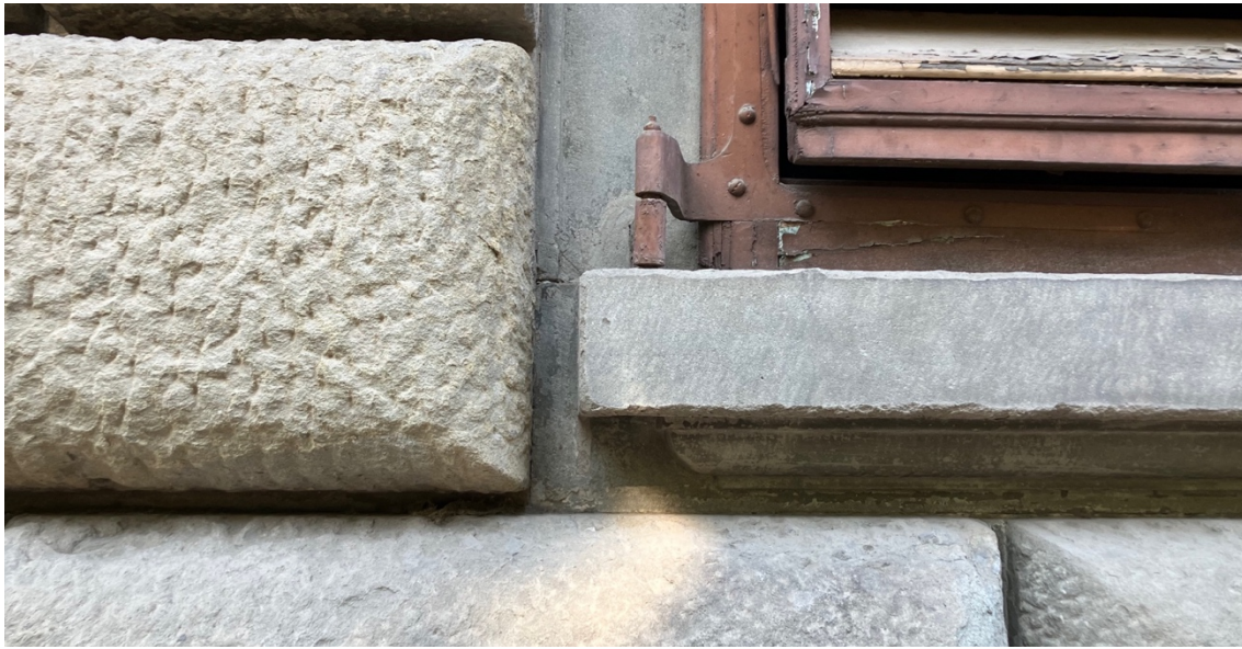
Fig. 2 – Dettaglio del piano terra dell'attacco dei conci di pietra serena con la cornice delle finestre, anch'essa in pietra serena.
