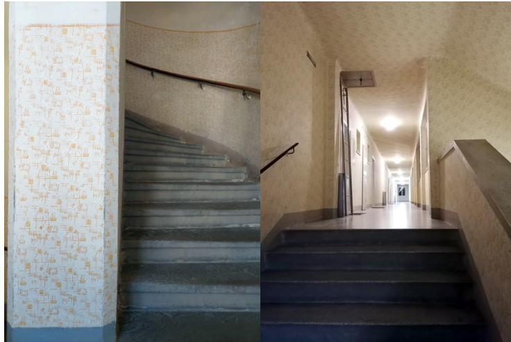
Fig. 1,2 – Stairwells, Beingasse & Jägerstraße / Vienna
