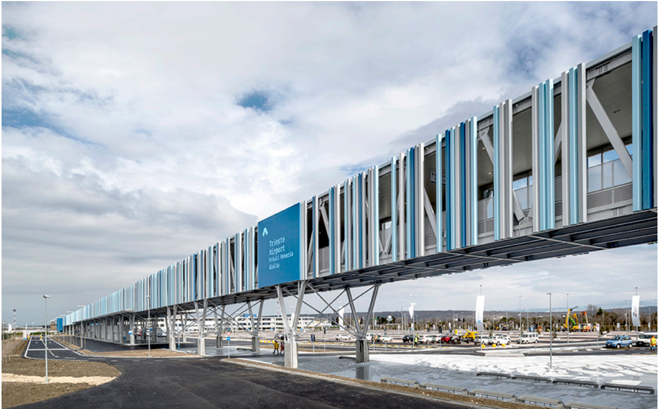
Fig. 3 – La facciata della passerella del Trieste Airport di FUD (fonte Trieste Airport)
